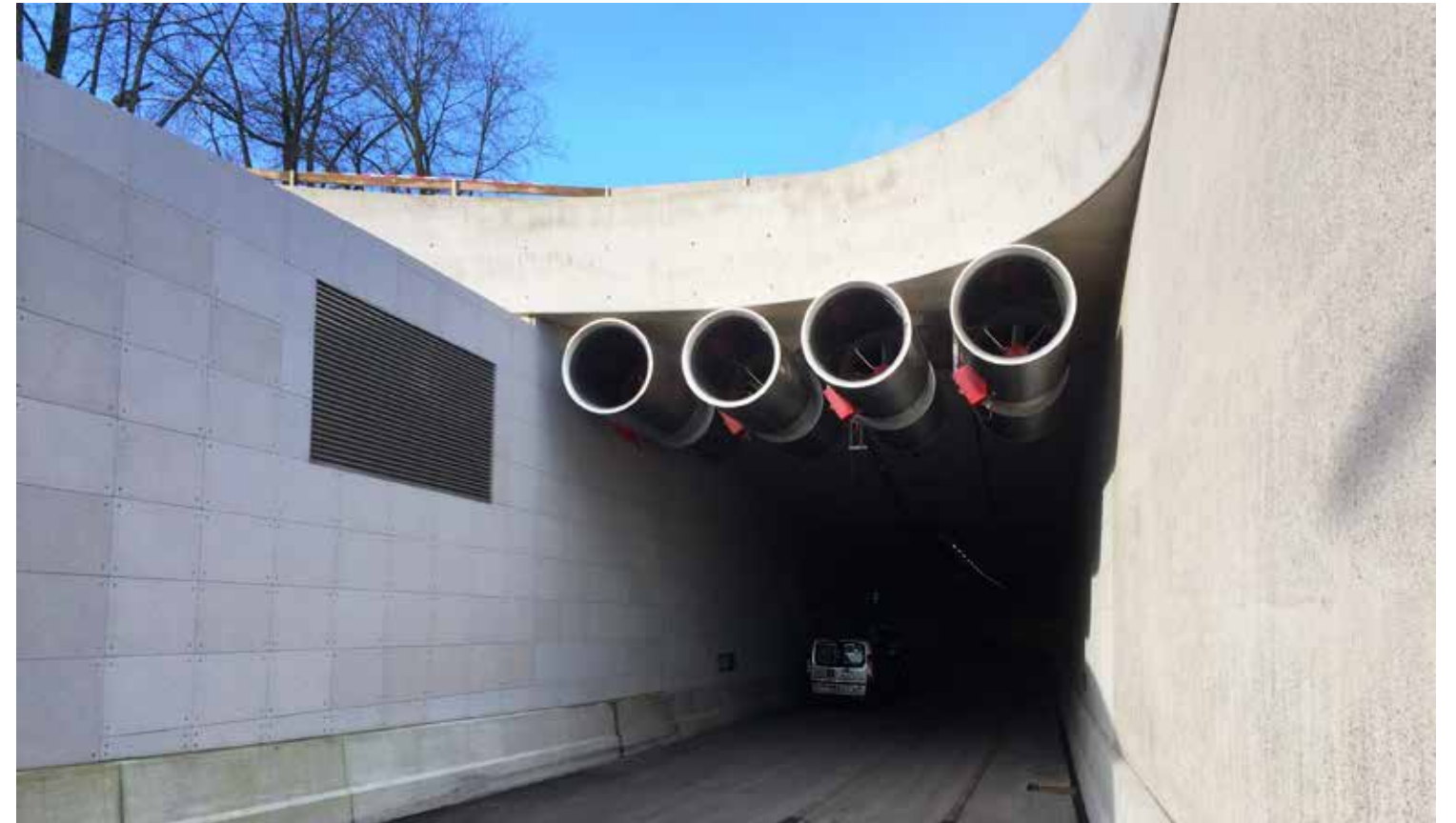
Stuwdrukventilatoren bij de ingang van de tunnel.
