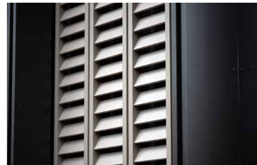
Van verduistering tot diffuse lichtdoortlaat tot de totale verlichting van een kamer, bijna alles is mogelijk door de luiken in de juiste positie te zetten.
