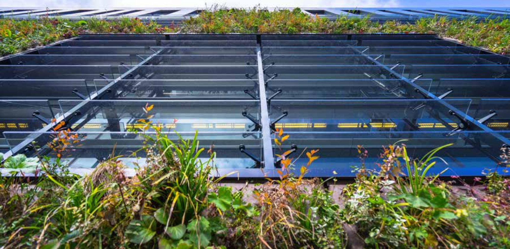
De glaslamellen zijn zonwerend en lichtdoorlatend.
