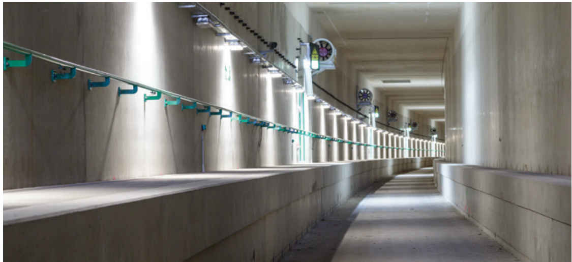
Werkzaamheden in de tunnel bij station Delft. (Foto: ProRail/Ronald Tilleman)
